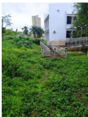
Figura 32: Rampa da Biblioteca sem conclusão
