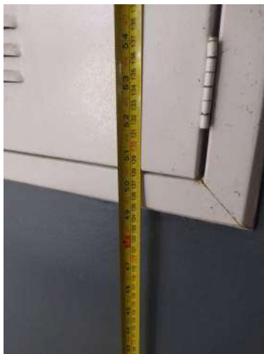
Figura 20: Bloco de aulas CAA
