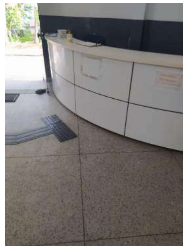
Figura 21: Bloco de aulas CAA
