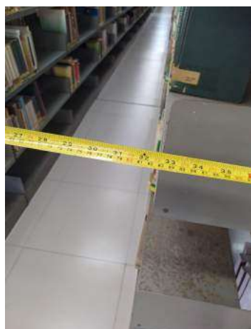
Figura 34: Largura dos corredores inconforme
